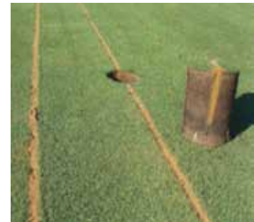
La rainure est remplie de sable jusqu'à 15 - 22,5 cm de profondeur.
